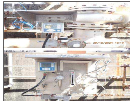
เครื่องตรวจวัด pH และ Conductivity บริเวณบ่อกักน้ำทิ้ง ขนาด 9,600 ลูกบาศก์เมตร
