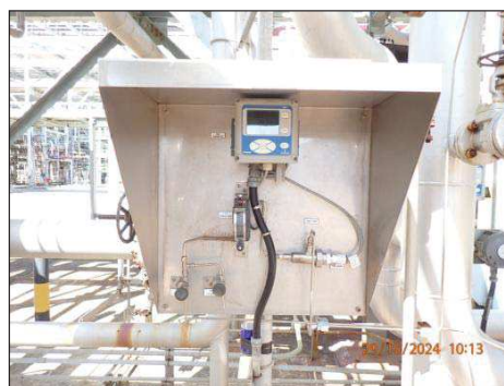
เครื่องตรวจวัด Conductivity บริเวณบ่อบำบัดน้ำทิ้งจาก WWI
