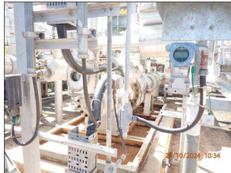
รูปที่ 3-36 อุปกรณ์ตรวจวัดความดันในระบบท่อลำเลียง
