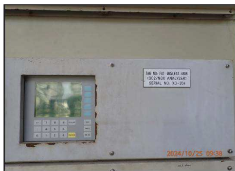
รูปที่ 3-4 เครื่องมือตรวจสอบคุณภาพอากาศจากปล่องแบบอัตโนมัติ (CEMS)
