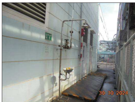
ฝักบัวและอ่างล้างตาฉุกเฉินที่ด้านข้างอาคาร
