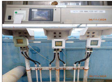
เครื่องตรวจวัด pH และ COD แบบอัตโนมัติ บริเวณบ่อบำบัดน้ำทิ้งจากระบบบำบัดน้ำเสีย (RO-BIO)
