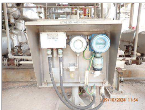
Gas Detector บริเวณที่เกี่ยวข้องกับสาร HCN
