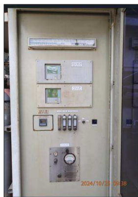
รูปที่ 3-4 เครื่องมือตรวจสอบคุณภาพอากาศจากปล่องแบบอัตโนมัติ (CEMS)
