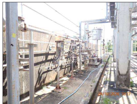
รูปที่ 3-12 ระบบรวบรวมน้ำฝนแยกจากระบบรวบรวมน้ำเสีย
