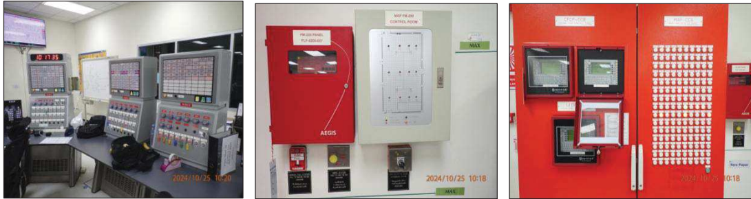
ตัวอย่าง Emergency shutdown system – ESD Control Panel ของ MMA Plant สามารถสั่งหยุดระบบกรณีพบการรั่วไหลได้ในห้องควบคุม
